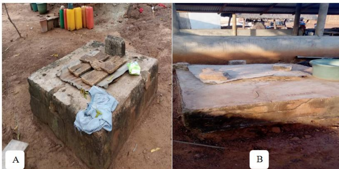
Planche N°1 : Des puits traditionnels non fonctionnels à Bognonzra Prise de vue : Aké-Awomon
