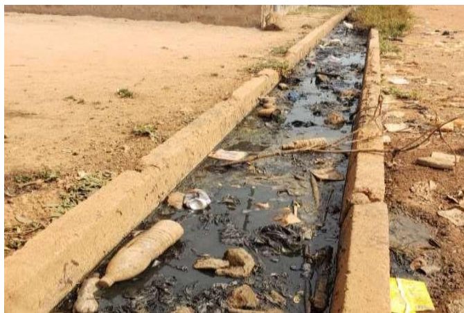
Photo 4 : Caniveau obstrué dans un quartier précaire d'Arrah
